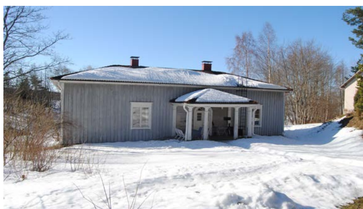
Bostadsbyggnaden från norr.
